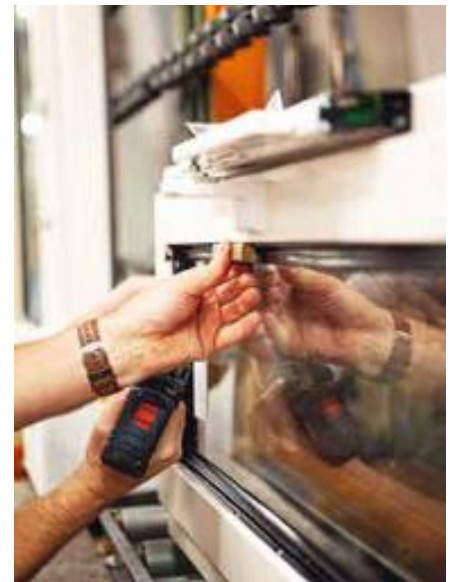
6. Schritt: Verschrauben Sie die Fixclip-Schiene mit dem Rahmen.
