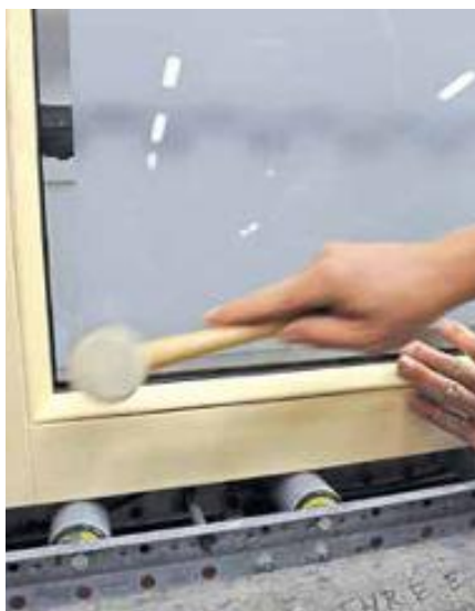
8. Schritt: Klopfen Sie die Glasleiste vorsichtig mit einem Schonhammer fest.
