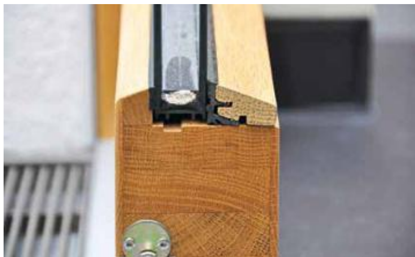
Die Fixclip-Schiene von Knapp befestigt die Scheibe und dichtet gleichzeitig den Glasfalz ab. Die Glasleiste klipst der Monteur dann einfach in das Profil ein.
