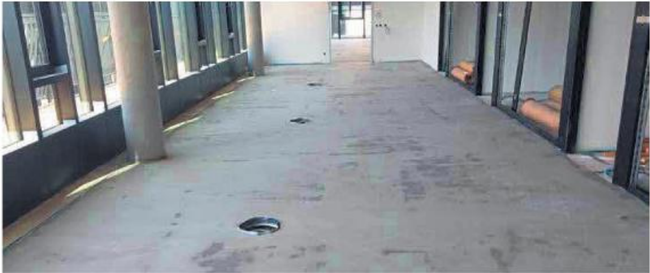
Das Raumklima übt einen entscheidenden Einfluss auf das Trocknungsverhalten von Estrichen aus.
