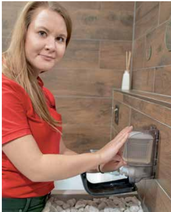
LINKS: Ein Nachspülen der Spender mit warmem Wasser ist nicht notwendig, da die Kartusche inklusive Pumpe ausgetauscht wird.
