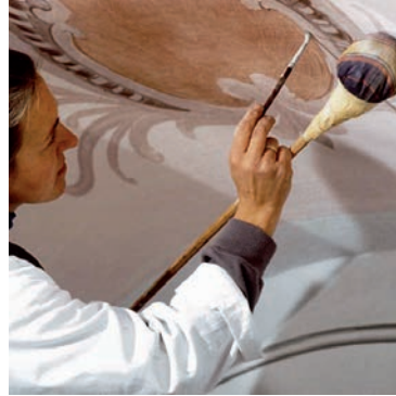
1.3 Ausmalen eines Deckenspiegels
