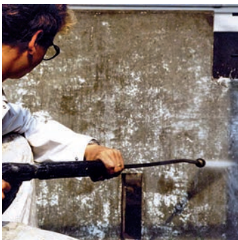
1.2 Fassadenreinigung mit dem Hochdruckreiniger
