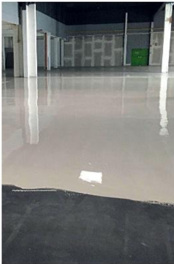
In einem ersten Bauabschnitt pumpten die Verarbeiter rund 15 Tonnen der Spachtelmasse „AS 1 Rapid“ auf den Boden, im zweiten Bauabschnitt etwa 12 Tonnen.
