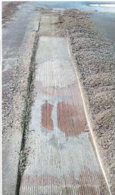
Die alten Schichten in der Halle waren sehr unterschiedlich. In einigen Bereichen mussten die Verarbeiter diese mit einer Spezialfräse abtragen.
