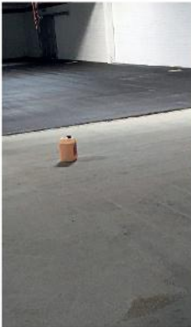
Mit der Grundierung „R 766“ konnten die Verarbeiter große Teile des Untergrunds schnell und sicher vorbereiten.
