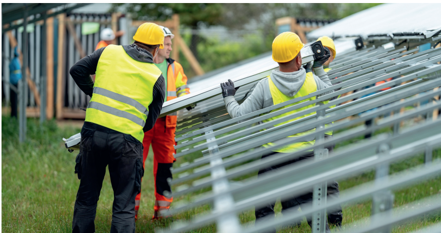
Mehr als die Hälfte des zukünftig 65.000 m 2 großen Kollektorfelds ist im Frühjahr 2025 bereits montiert.
