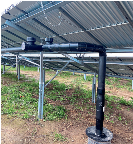
Die Kollektoren werden höher aufgestellt (Unterkante 90 cm hoch). So können später Pflanzen und Tiere sich auf der riesigen, nicht öffentlichen Fläche optimal ansiedeln.
