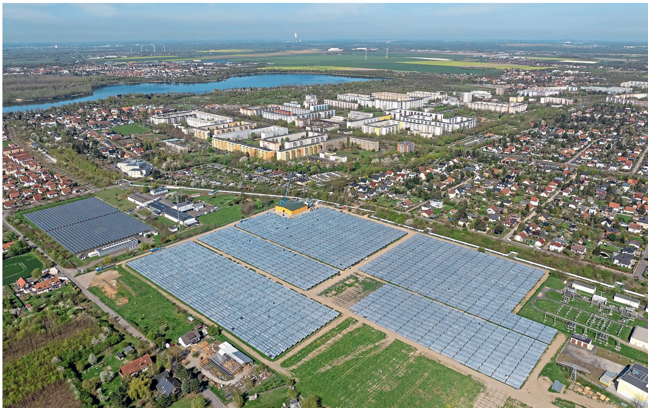
Aus der Vogelperspektive: Die Solarthermie-Baustelle der Leipziger Stadtwerke im Stadtteil Grünau wächst. Die Anlage soll Ende 2025 in Betrieb gehen.
