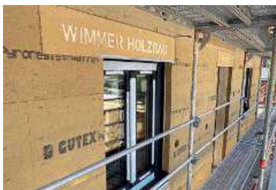
Vorgefertigte Holzwände wurden passgenau vor das bestehende Mauerwerk montiert und bilden die neue, energieeffiziente Gebäudehülle.
