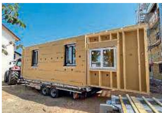
Anlieferung eines komplett vorgefertigten Wandelements: So reduziert sich der bauliche Aufwand vor Ort auf ein Minimum.
