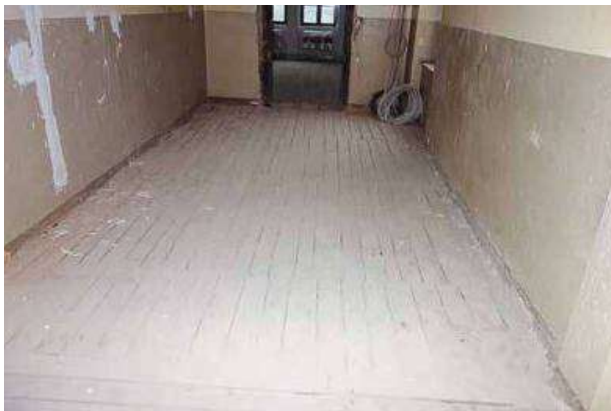
Dielenboden in einem Sanierungsobjekt.
