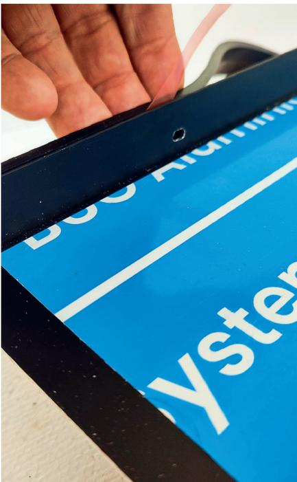
**4. Schritt:** Ziehen Sie die Schutzfolie des Dichtklebebands schrittweise ab und drücken Sie die Anschraubdichtung über den gesamten Fensterbank-Anschraubsteg fest an.
