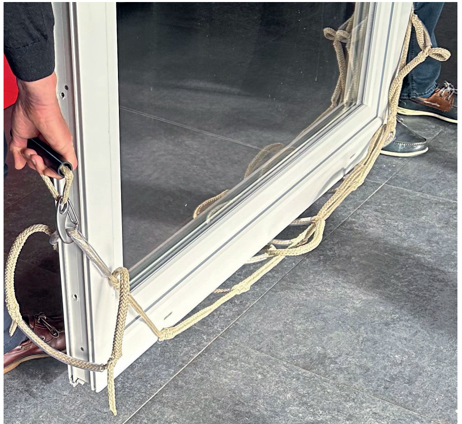
5. Schritt: Heben Sie den Fensterflügel mit zwei Personen an.
