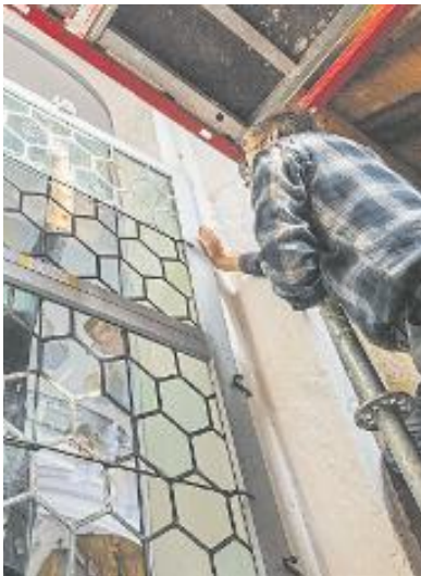
Um die lichtempfindlichen Gemälde in der Kirche zu schützen, wurde Glas mit integriertem UV- und Infrarotfilter entwickelt.
