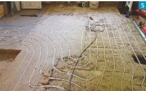
4 Die Heizungsrohre wurden in einen gerissenen und teilweise zerbrochenen Altestrich verlegt.
