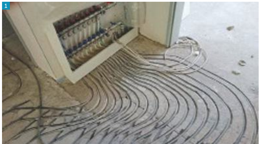
1 Heizungsrohre in den eingefrästen Estrich verlegt.
