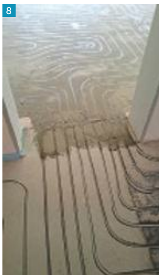
6 Der Altestrich wurde mit einer abgequarzten Reaktionsharzgrundierung grundiert, ein Randdämmstreifen war nicht vorhanden.
