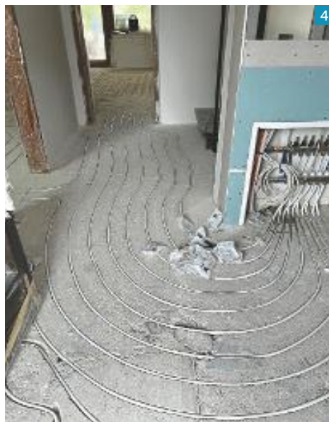
4 Die Heizungsrohre wurden in einen gerissenen und teilweise zerbrochenen Altestrich verlegt.
