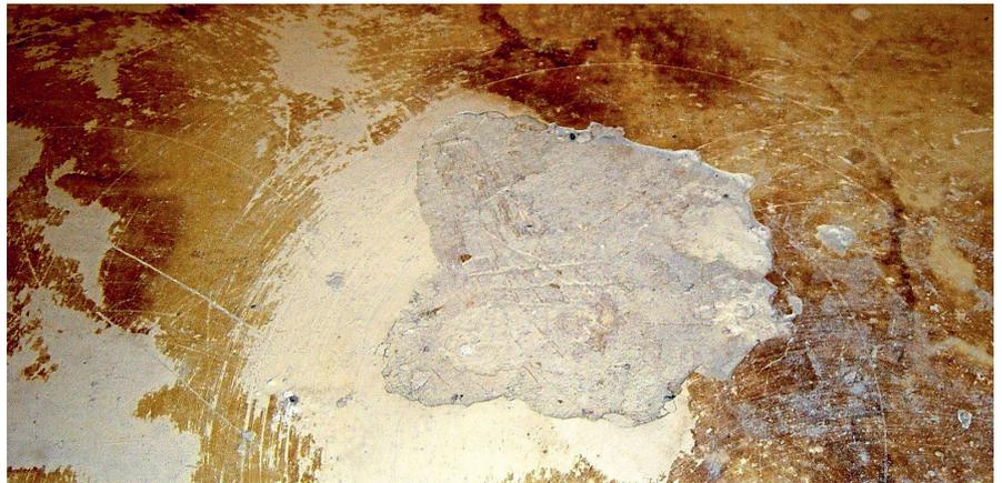
Sulfitablaugekleber müssen zwingend mit einer Reaktionsharzgrundierung abgesperrt werden, wenn Gerüche aus dem Untergrund verhindert werden sollen.
