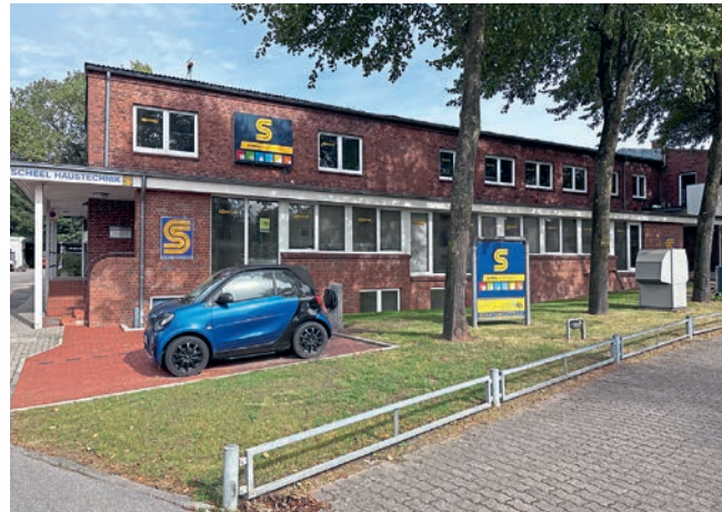
Das Scheel-Haustechnik-Gebäude in Itzehoe im Südwesten Schleswig-Holsteins.
