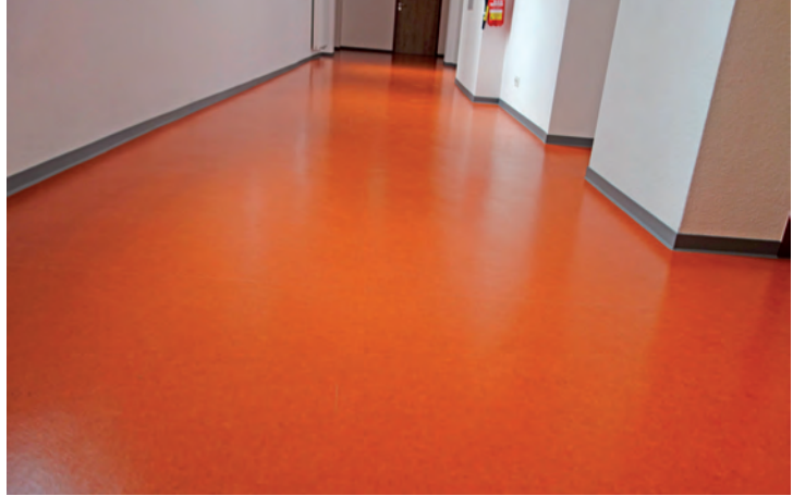
Abb. 46: Bei der Linoleumverlegung ist darauf zu achten, dass die Bahnen richtungsgleich zu verlegen sind
