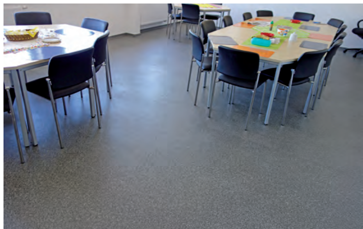
Abb. 45: Aufstandsflächen und Möbelgleiter müssen auf den Bodenbelag und die Verlegewerkstoffe abgestimmt sein
