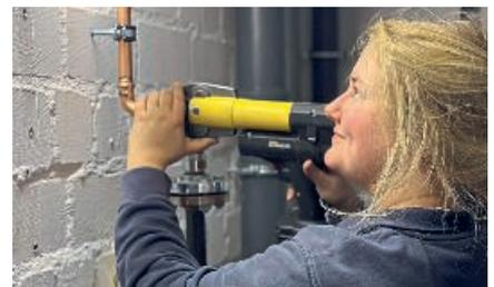
Verlegung einer neuen Gasleitung mit Pressverbindung von Kupferrohr.
