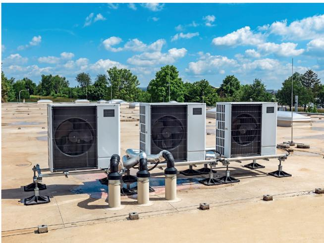
Für die Beheizung und Kühlung des nach KfW-Energie-Standards gedämmten Gebäudes kommen drei Luft-/Wasser-Wärmepumpen von Mitsubishi Electric als Kaskade zum Einsatz.
