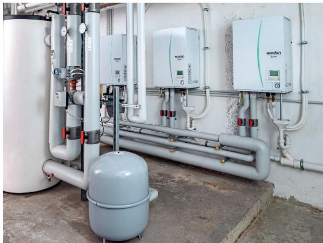
Für jede Außeneinheit befindet sich im Technikraum ein Hydromodul mit Wärmetauscher-Einheit.
