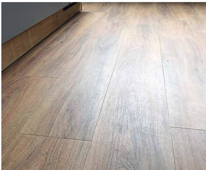
OBEN: Vinylbeläge sind in zahlreichen Ausführungen erhältlich – als Klick-Paneele (Bild) oder lose Paneele, Fliesen oder Rollenware, mit oder ohne Trittschalldämmung, mit Polyurethanbeschichtung oder klassisch in Natur.
