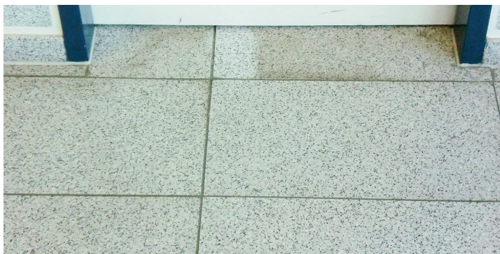
Bild 4: Musterfläche im Obergeschoss: Es wurde...
