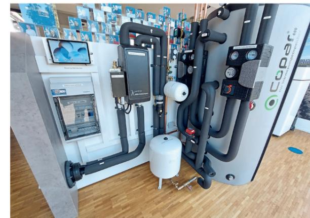
Blick in die Ausstellung mit einem Copar-Speicher, der Inneneinheit einer Lambda-Wärmepumpe und vorgefertigten Baugruppen für eine zügige Installation.
