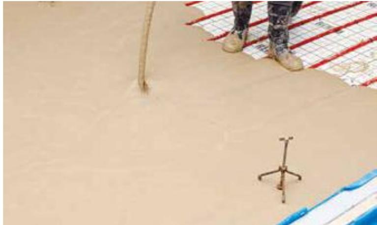
Fließestricheinbau auf Fußbodenheizung.
