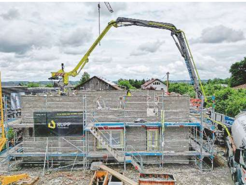
Serielles Bauen: Während im Erdgeschoss bereits die Windowment-Elemente mit Fenstern von Gugelfuss eingebaut sind, wird im Obergeschoss weitergedruckt.
