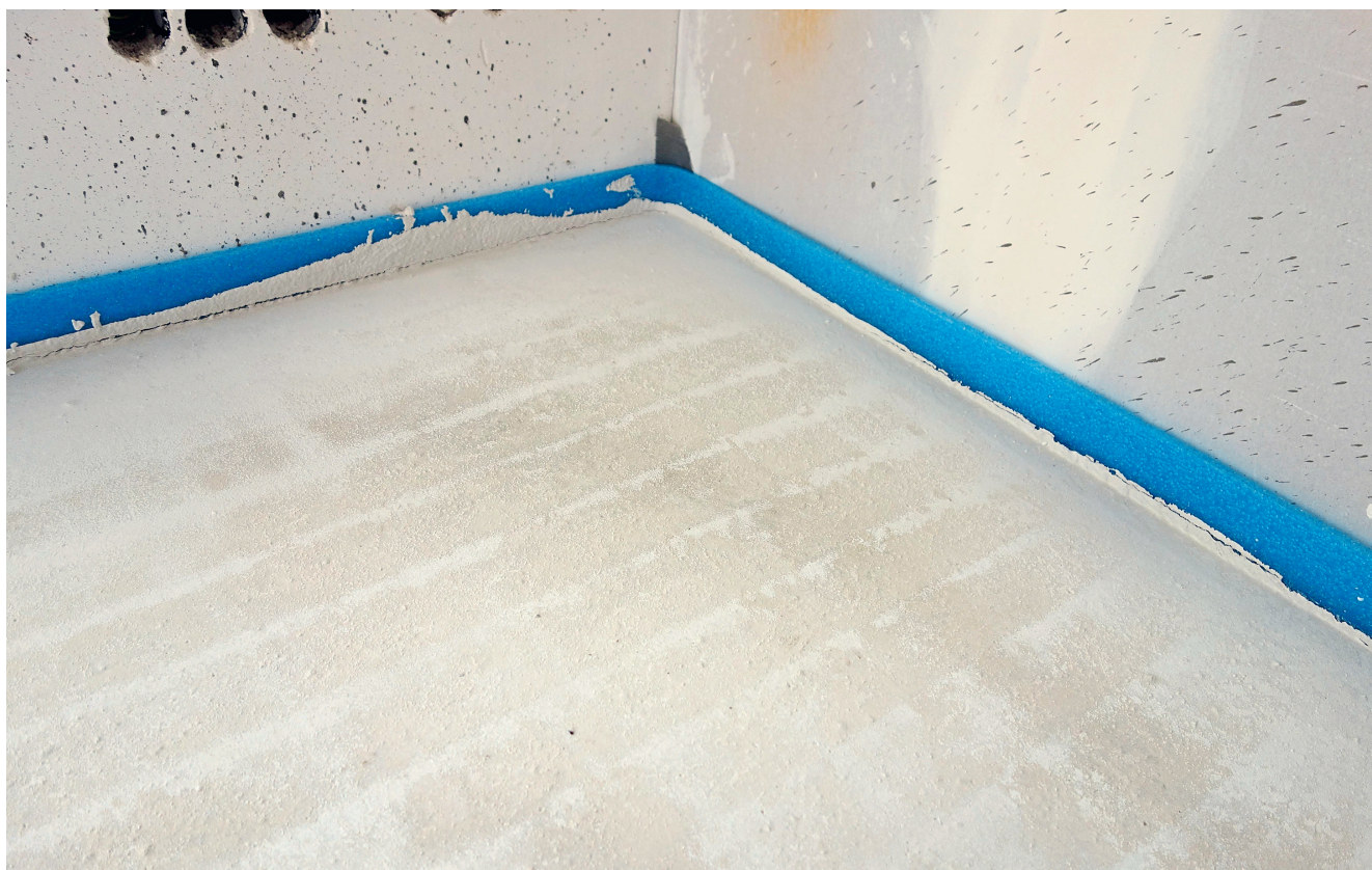
Fachgerecht eingebauter Randdämmstreifen.
