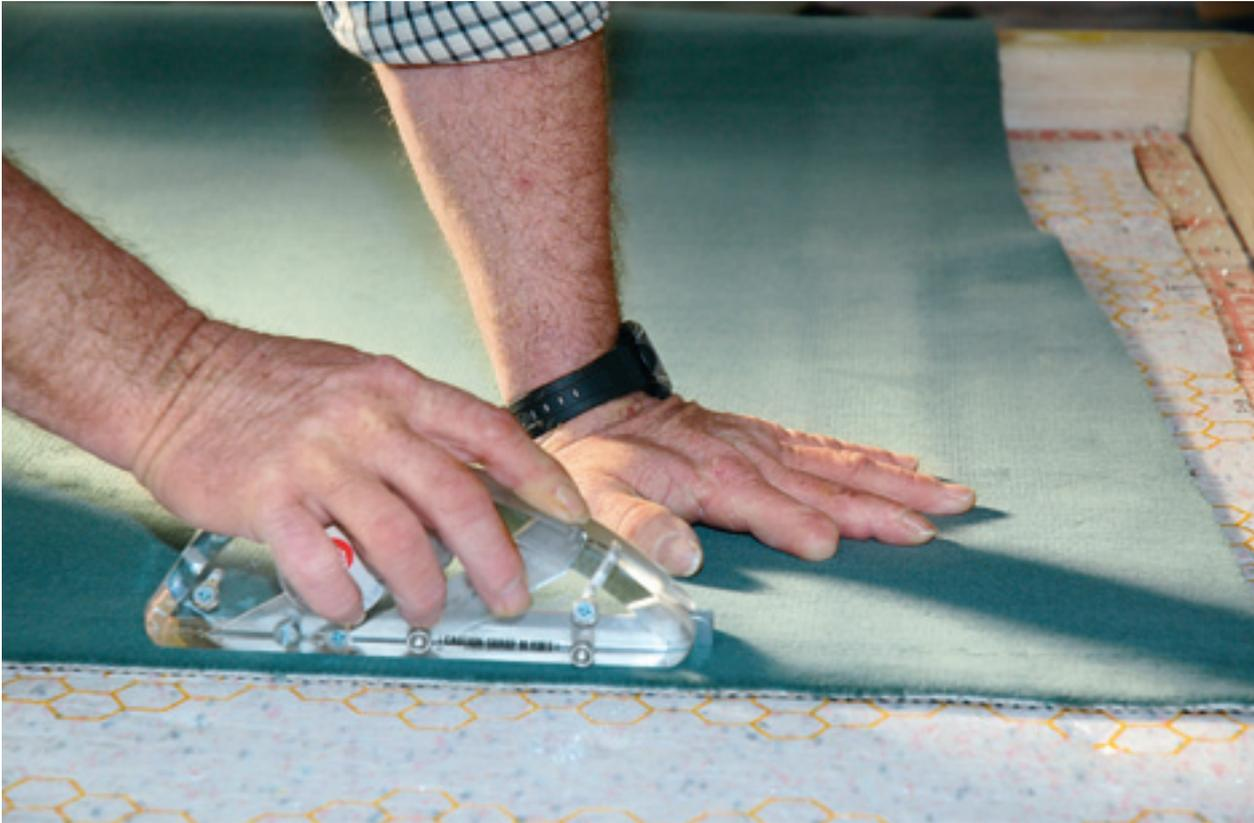
*Passgenauer Schnitt: Der Acrylschneider ist erforderlich, wenn eine exakte Nahtbearbeitung gelingen soll.*
