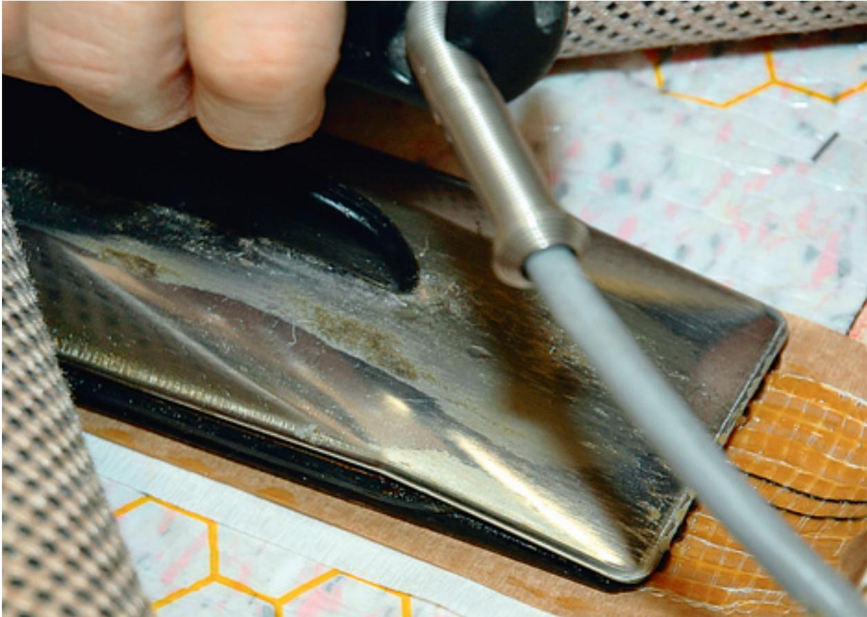
*Maßanzug fürs Wohnzimmer: Hier wird das Konfektionsgerät mittig auf das Multiline-Heißklebeband aufgesetzt. Durch das Schmelzen des Prozesswerkstoffs lassen sich die beiden Belagbahnen entlang der Naht kraftschlüssig verbinden.*
