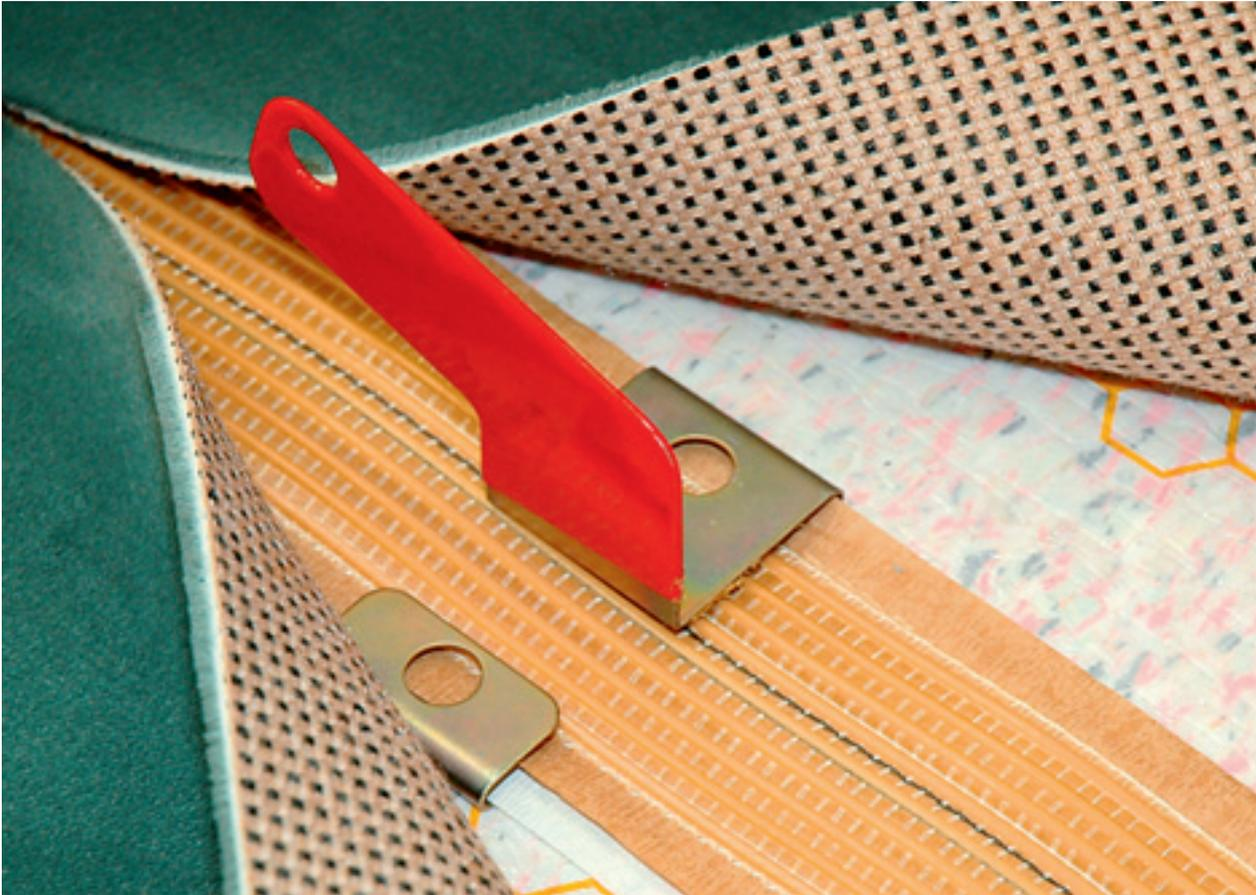
*Vorhang auf: Vor dem Konfektionieren werden auf der Unterlage der Reihe nach Silikonpapier und Schmelzklebeband in das Zentriergerät eingelegt.*
