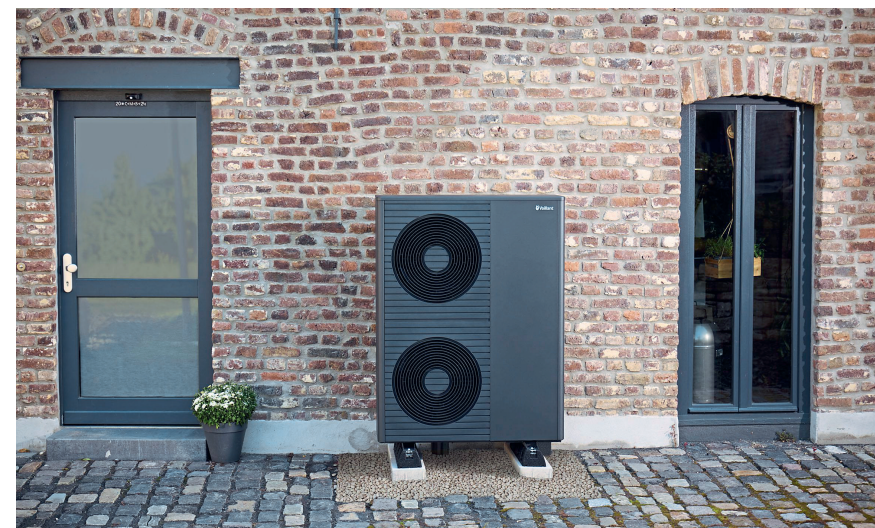
R290 hat sehr gute thermodynamische Eigenschaften, eine hohe Effizienz auch bei höheren Vorlauftemperaturen und vor allem ein extrem niedriges Treibhauspotenzial. Das macht es zu einem Schlüsselbaustein der Wärmepumpentechnologie.
