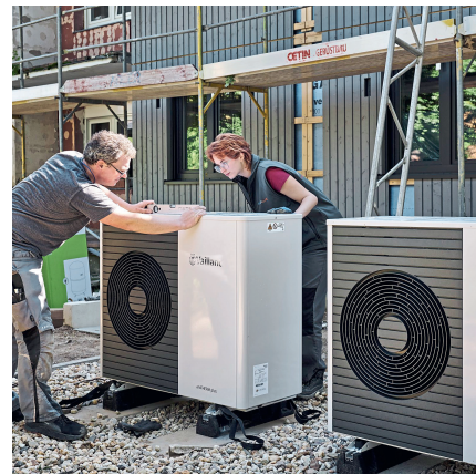
Die Sicherheitsabstände für Wärmepumpen mit R290 leiten sich aus dem ungünstigsten denkbaren Leckagefall ab. Das bedeutet: Montageanleitungen der Hersteller sind bindend und auch Teil der Aufstell- und Koordinationsplanung.
