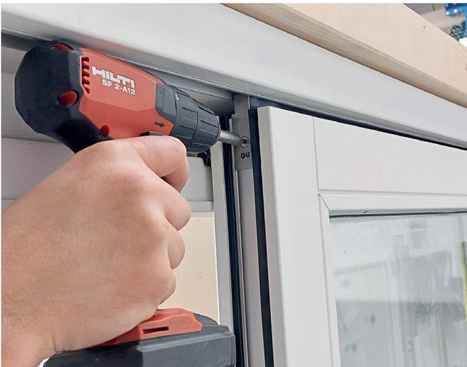
**3. Schritt:** Richten Sie den Flügel mittig zur oberen Führungsschiene aus, führen Sie die vordere Führung in die Führungsschiene ein und montieren Sie diese an der vorgesehenen Stelle am Flügel.
