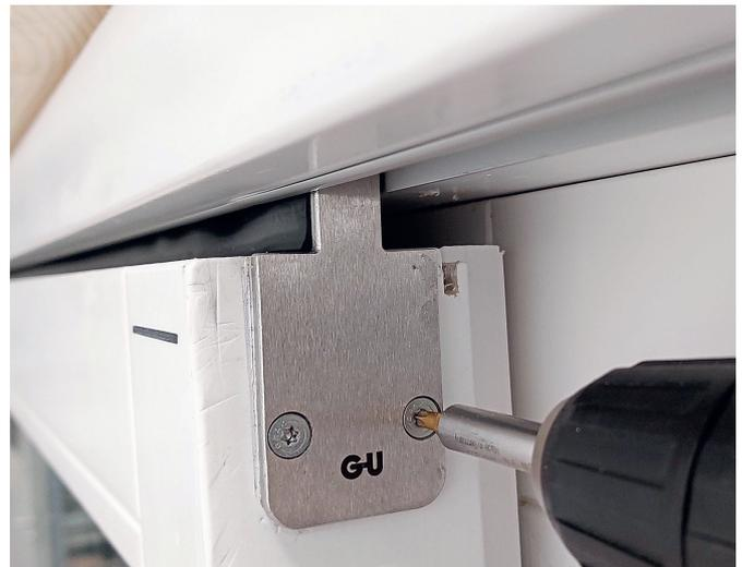
**4. Schritt:** Montieren Sie die hintere Führung am Flügel. Dazu führen Sie die Führung in die Schiene ein und verschrauben sie anschließend mit dem Flügel.
