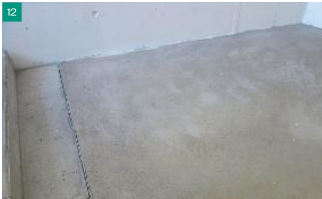
Ein abgeschnittener Randdämmstreifen muss nachgebessert werden.
