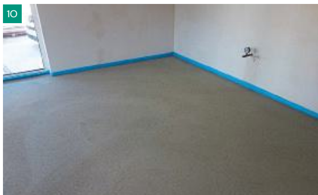
So sieht ein fachgerecht eingebauter Randdämmstreifen aus.
