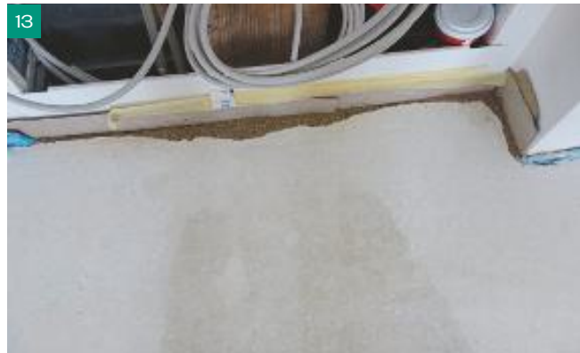
Hier wurden die Fehlstellen mit einem Epoxidharzmörtel geschlossen.
