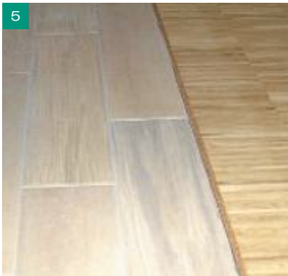
Hier wurde die Bewegungsfuge mit einem Korkstreifen ausgebildet.
