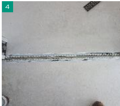
Das Fugenprofil im Türbereich.
