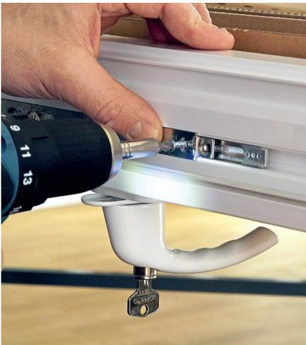
5. Schritt: Montieren Sie die neuen Beschlagteile aus dem Nachrüstpaket im Fensterflügel und im Fensterrahmen.
