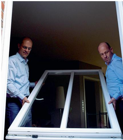
6. Schritt: Hängen Sie den Fensterflügel ein. Positionieren Sie die Schließbleche mittels Positionierhilfe und schrauben Sie sie fest.
