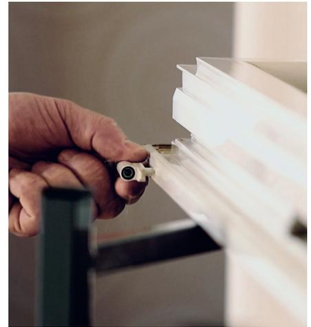
4. Schritt: Demontieren Sie die alten Beschlagteile sowohl im Fensterflügel als auch im Fensterrahmen.
