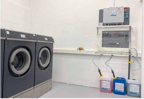
Mit einer smarten Dosieranlage lassen sich mehrere Maschinen automatisch über nur eine Pumpe versorgen und aus der Ferne effizient überwachen sowie digital steuern.
