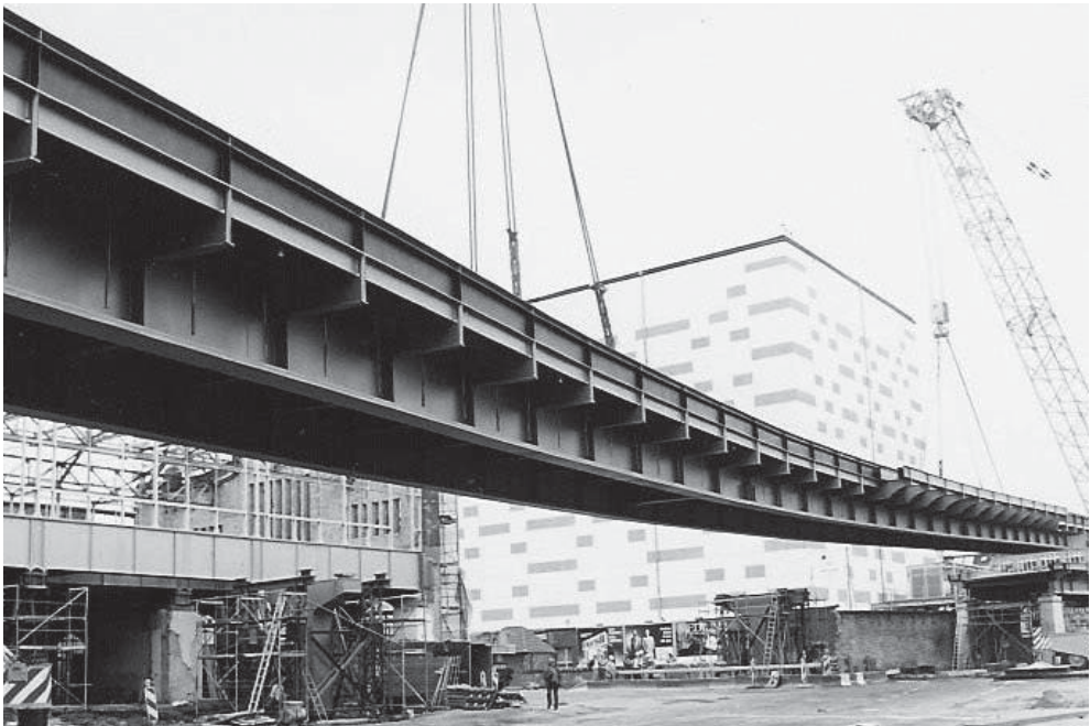
Abb. 7.1: Brückenmontage an einer Kreuzung (Foto: Konrad Micksch)
