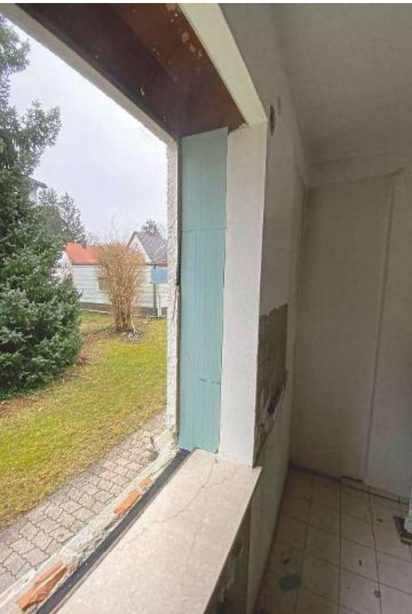
Glattstrichplatte einsetzen und mit dem Mauerwerk verkleben, Multifunktionsband anbringen, Fenster setzen – fertig: So einfach funktioniert die Montage von Fenstern in der Renovierung mit dem Glattstrichsystem von Multimont.
