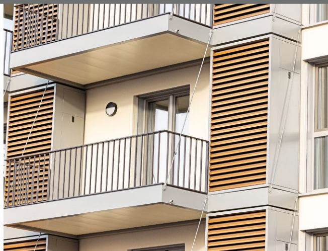
Blick auf die verkleideten Außeneinheiten mit Verbindung zu den Balkonen.
