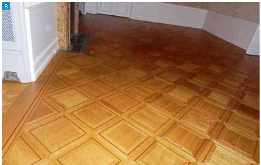
5 Rückbau des beschädigten Tafelparketts.
