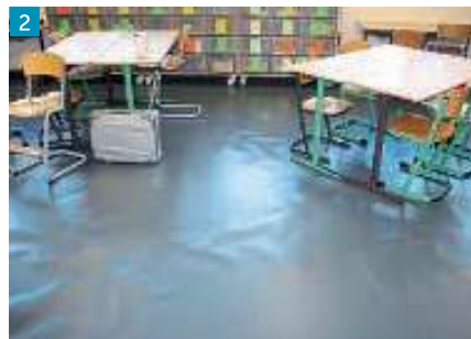
1 Die Designplanken wurden im Randbereich zu spät eingelegt – Folge: Beulen im Belag.
