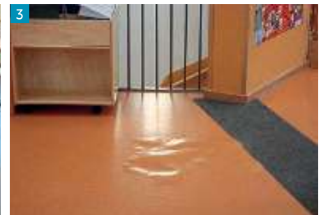
1 Die Designplanken wurden im Randbereich zu spät eingelegt – Folge: Beulen im Belag.
