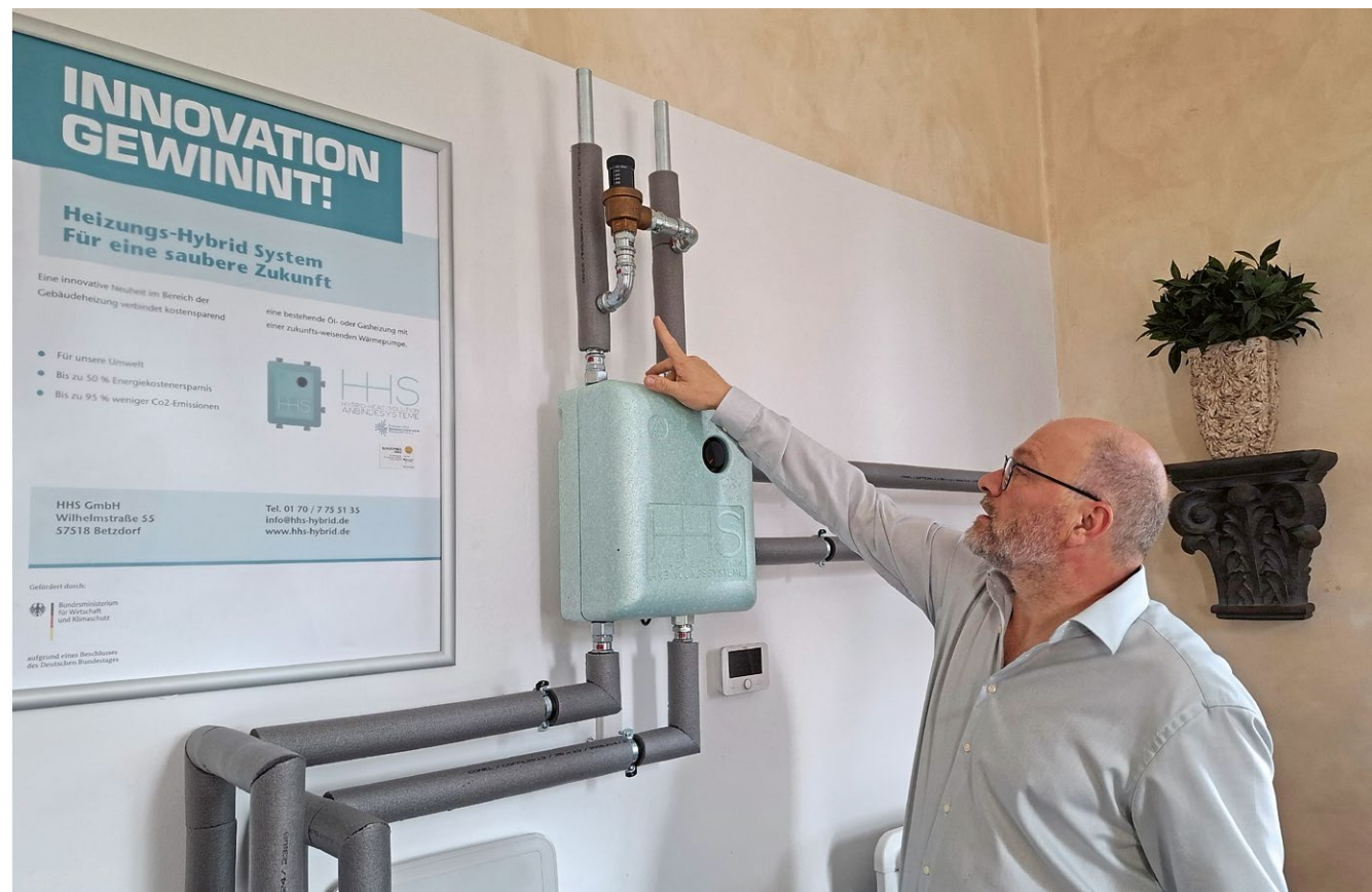
Peter Brecklinghaus erklärt die hybride HHS-Box in den Schulungsräumen in Wallmenroth im Landkreis Altenkirchen. Mit dem patentierten und mehrfach prämierten System können SHK-Handwerker ihren Kunden einen preiswerten Umstieg auf CO 2 -armes Heizen bieten. Es sind keine Umbaumaßnahmen notwendig.
