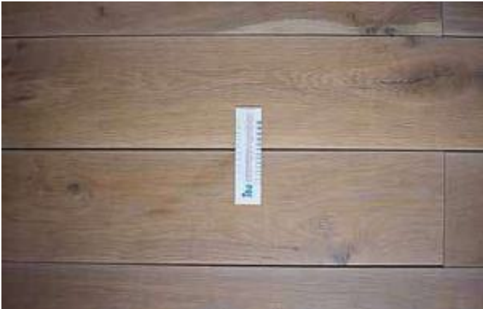
Bei genauer Betrachtung zeigen sich jedoch offene Fugen > 0,5 mm...
