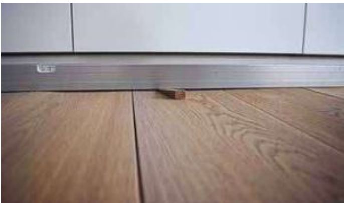
Außerdem erkennbar sind Aufschüsselungen > 4,0 mm bis < 6,0 mm, lokal 8,0 mm auf kurzen Nennmaßbereichen...
