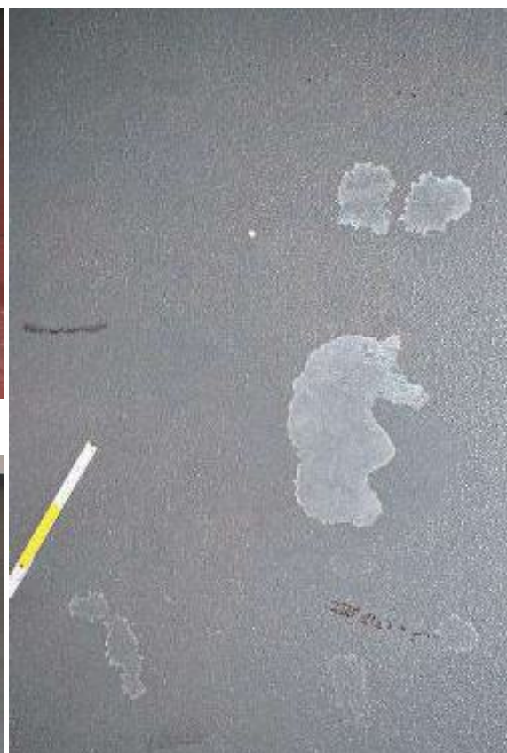
Bodenbeschichtung mit Abplatzungen und Enthaltungen.
