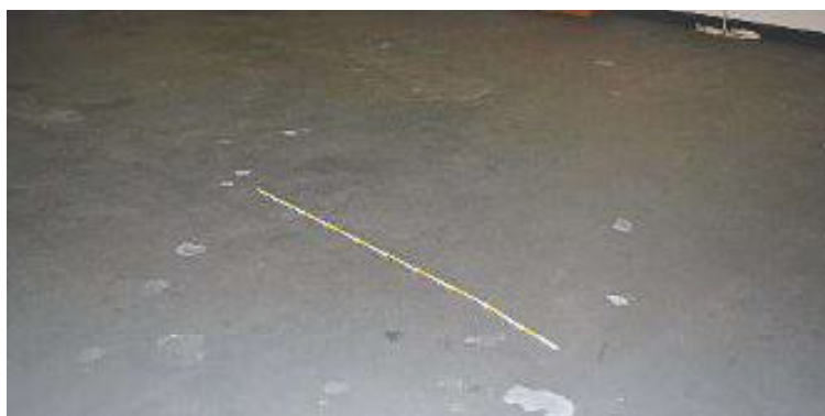
Bodenbeschichtung mit Abplatzungen und Enthaltungen.
