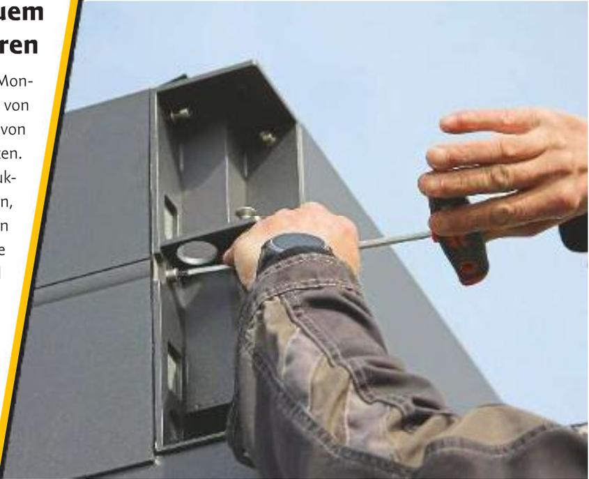
Vereinfachte Montage mit der neuen Eckverbindung Ausführung B: An den Ecken werden die seitlichen Rahmenelemente der Terrassenüberdachung und die Stützen verschraubt – im Anschluss verdeckt eine Kappe die Schrauben.
