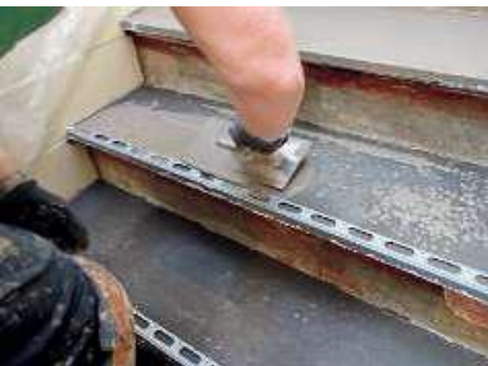
Ausgleichen der Trittstufen mit einer standfesten Spachtelmasse.
