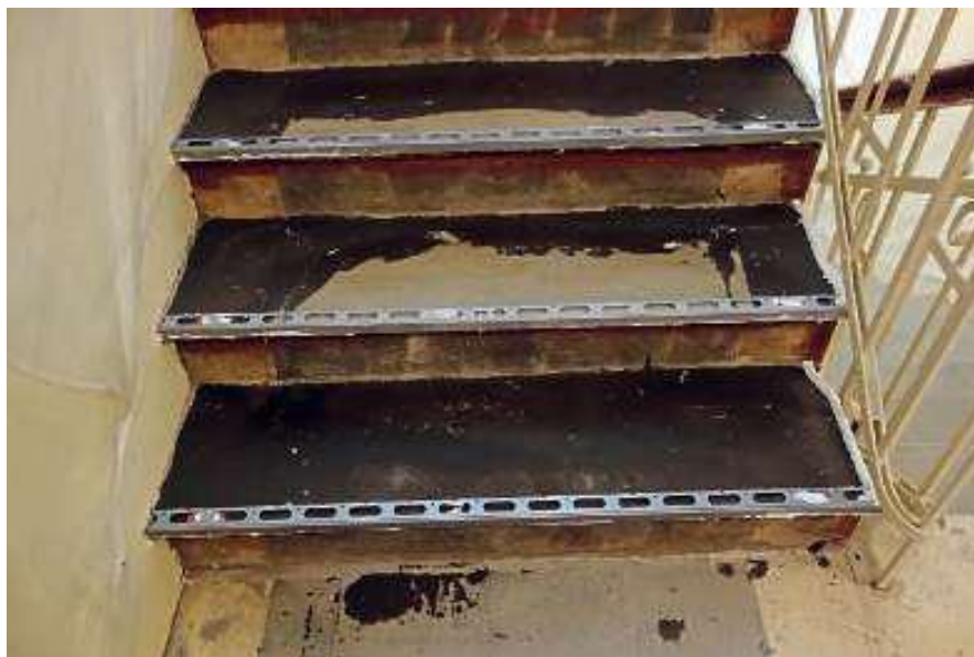
Montage von Treppenwinkeln an den Treppenkanten.
