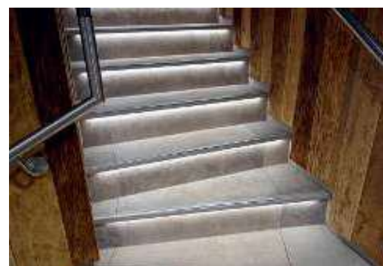
Ein intensiv beleuchteter Treppenlauf in einem dunklen Treppenhaus bietet zusätzliche Sicherheit.
