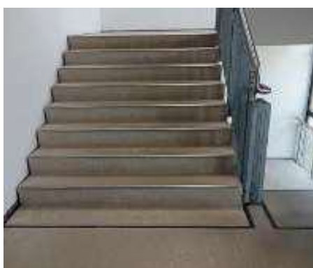
Stahlbetontreppe aus Sichtbeton mit deutlicher Bewegungsfuge.
