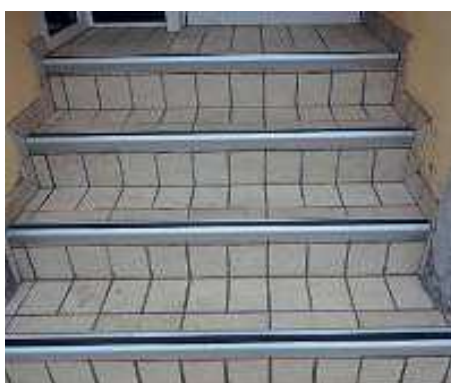
Deutlich markierte Treppenkannten sorgen für größte Sicherheit.
