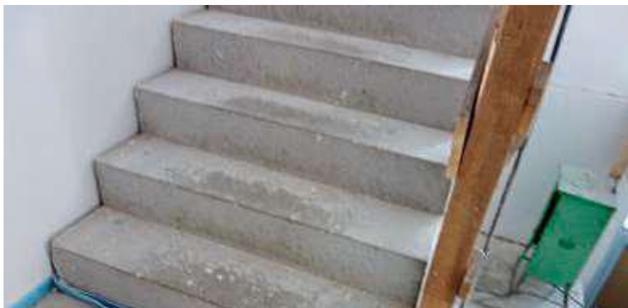
Stahlbetontreppe mit Bewegungsfuge.
