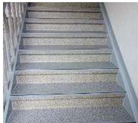
Fachgerecht sanierte Holztreppen.
