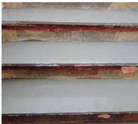
Vollständig gespachtelte Trittstufen der Holztreppe.
