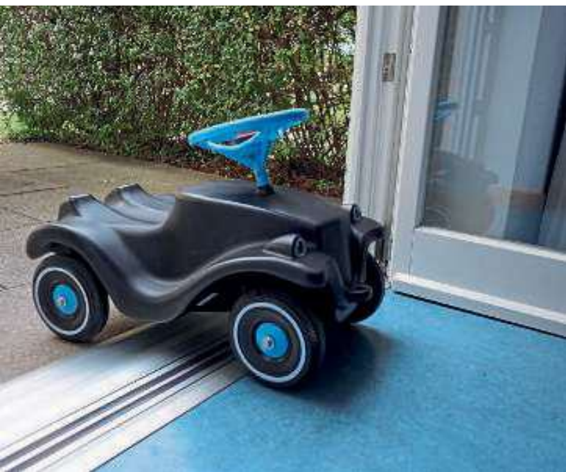
Egal ob jung oder alt – die beweglichen Dichtungen, die den starren Türanschlag ersetzen, bieten für alle eine hervorragende Ergonomie, auch im Altbau.
