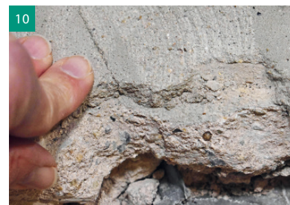
10 Falten in der Schrenzlage – Risse im Estrich.
