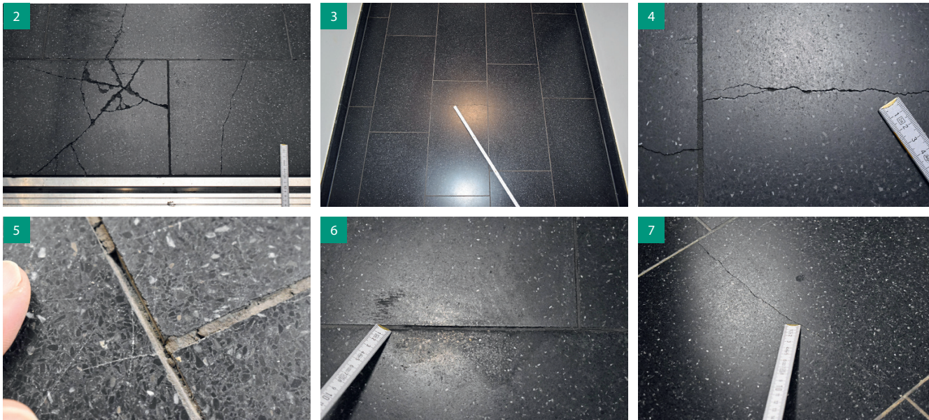
2 Zerbrochener Betonwerkstein im Aufzug.
