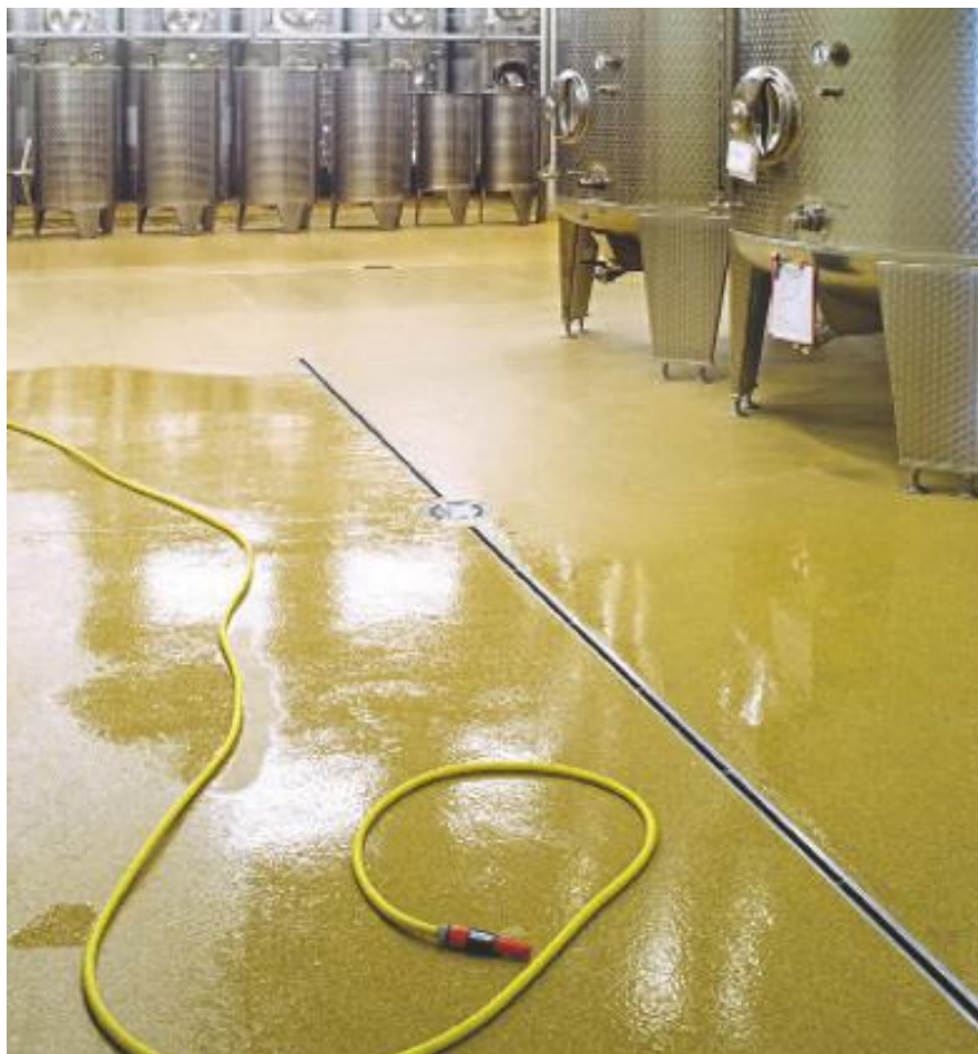
„Einer der häufigsten Fehler ist eine unzureichende Untergrundbeurteilung“, sagt Silikal-Geschäftsführer Hubert Weimann. Das Bild zeigt den Einsatz im Weinkeller – dort muss der Boden gleichzeitig hygienisch und belastbar sein.
