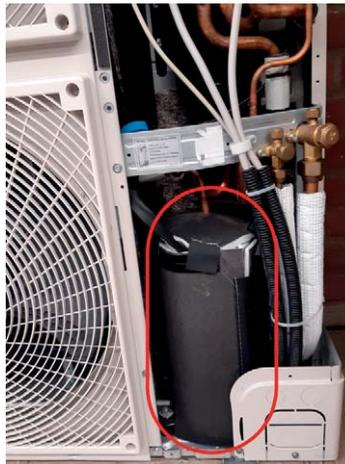
**Abbildung 3.1:** Kältemittelverdichter in einer Mono-Split-Außeneinheit
