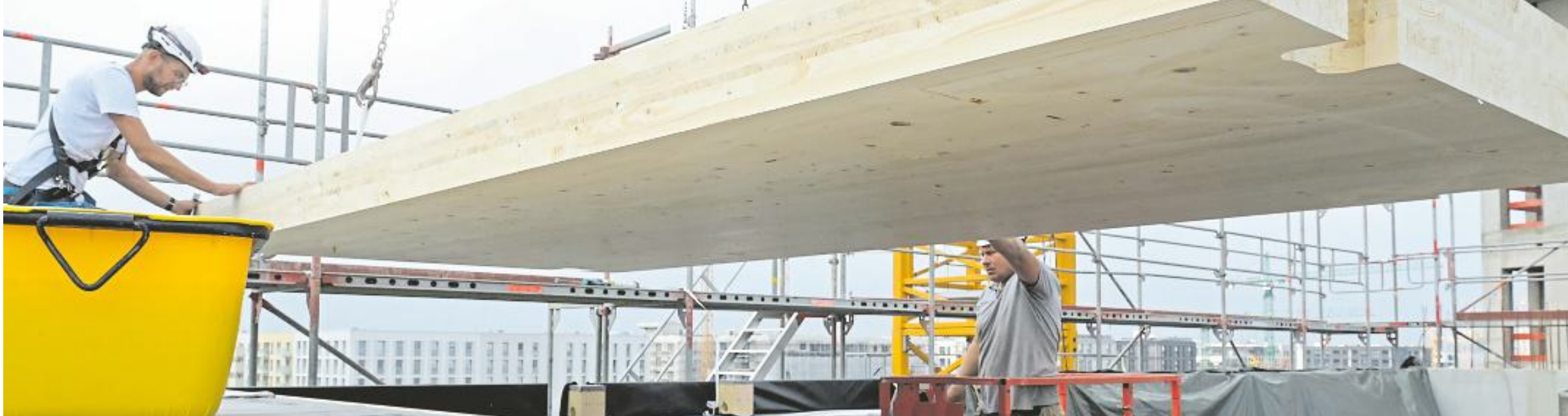
Häuser aus Holz erfreuen sich steigender Beliebtheit. Im Holz steckt das Potenzial, die Ökobilanz des Bauwesens nachhaltig zu verbessern.
