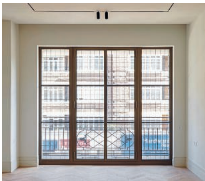
Schlanke Ansichten, hohe Wärmedämmung: Das Ziel war eine thermisch optimierte Nachbildung der Originalfenster ohne Sekundärverglasung.
