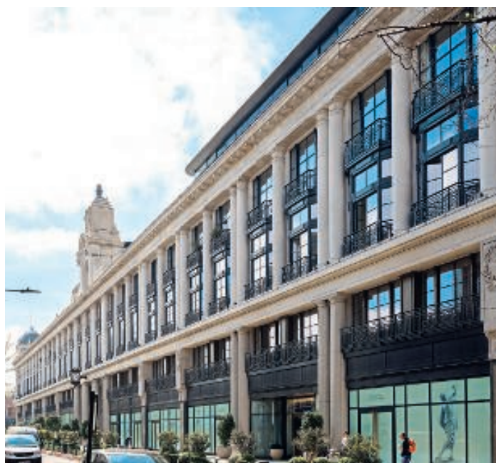
Die gebogenen und gewölbten Fenster stellte Propak einzeln und von Hand in seinem Werk in Hertfordshire her.
