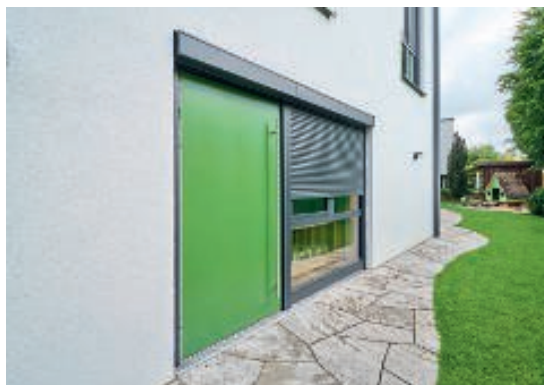
Die Abdunkelung der Schlafräume erfolgt mithilfe des Rollladensystems heroal RS 37.
