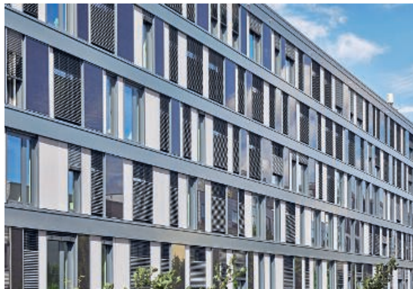
Durch den hohen Vorfertigungsgrad der Elemente ließ sich bereits zu einem sehr frühen Zeitpunkt eine Wetterdichtigkeit erreichen.
