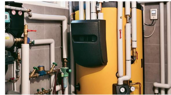
Familie Schmidbauer beheizt ihr 185 m<sup>2</sup> großes Haus mit einer Pellets-Solar-Kombi-Anlage von KWB. Auf dem Dach ist eine PV-Anlage. Die Wärmequellen verbindet ein Pufferspeicher, der mit dem KWB-EmpaFresh-Frischwassermodul ausgestattet ist.
