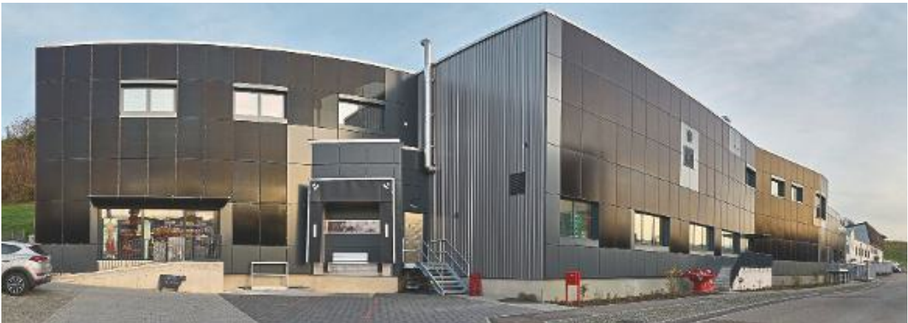
Im Sommer 2025 wurde das Metzgerhaus in Füllinsdorf in Betrieb genommen, ein neuer regionaler Schlachthof – klein, transparent und tierfreundlich.
